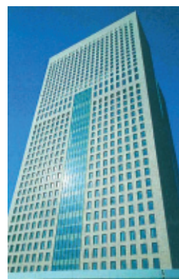
▲ 資生堂總部大樓外牆一瞥
