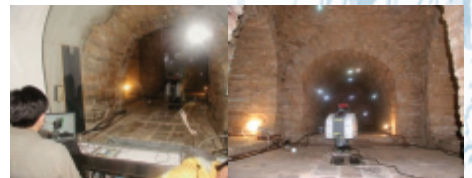
▲ 測量人員正在操作激光掃描機
