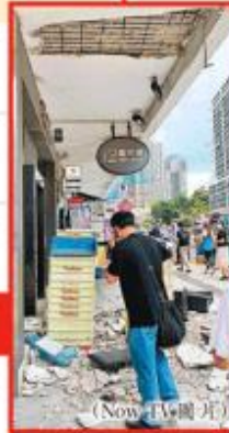
■長沙灣道七百九十四至七百九十六號早前簷篷大幅石屎塌下，碎片四散行人路（下圖），簷篷現已架起竹棚進行維修（左圖）。（黃勁坤攝）
